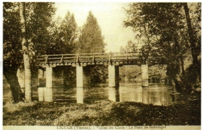
Pont de bois reliant Ligugé, construit en 1833
